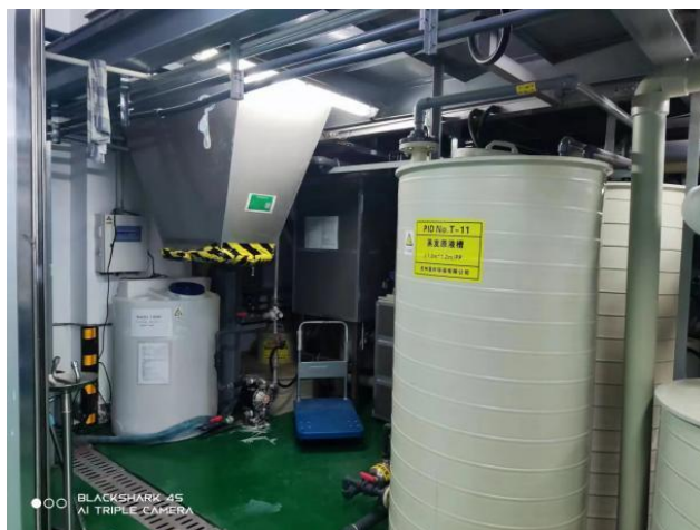
现有废水处理站照片
