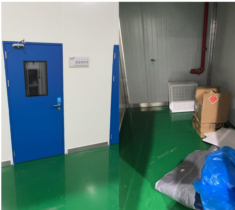
现有项目一般固废仓库照片
